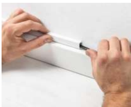
5. Inserire i cavi. Install cables.
